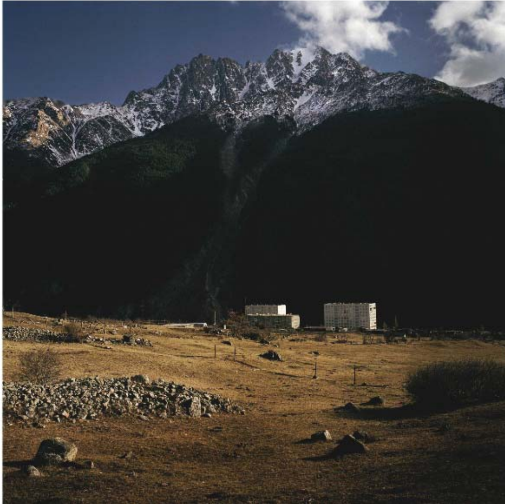
KABARDINIEN-BALKARIEN Relikte aus Sowjetzeiten sind diese Bauten am Elbrus, dem mit 5642 Metern höchsten Berg des Kaukasus. Einst waren sie Teil einer Station zur Erforschung von Elementarteilchen; die Region ist fast völlig abgeschnitten von jeder Entwicklung
